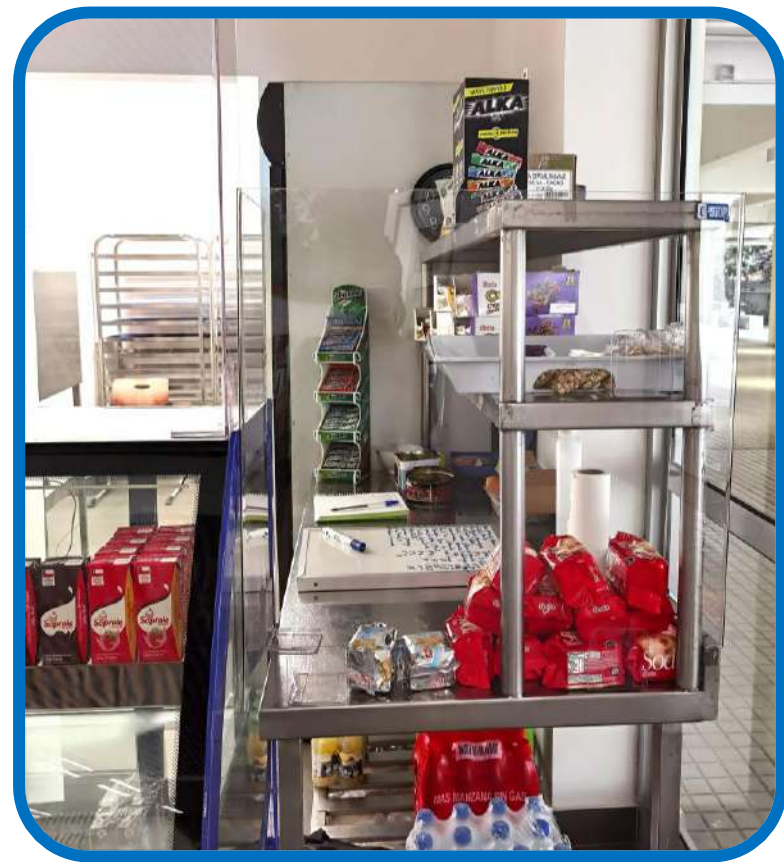
Resultado de la fabricación e instalación de barreras
